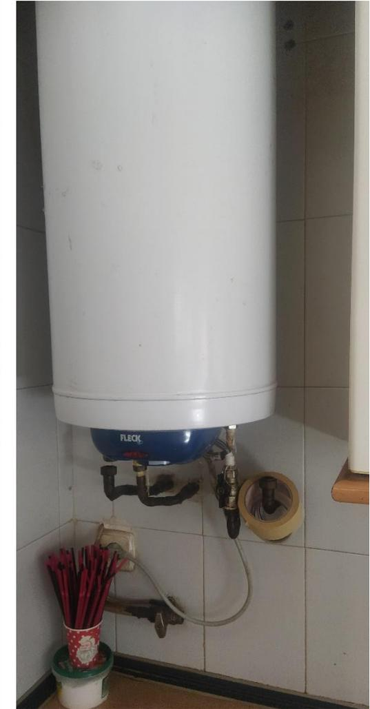
Sustitución de caldera de gas para ACS y calefacción por un termo eléctrico de ACS de alta eficiencia al estar el sistema de calefacción por gas condensado por otras averías.
